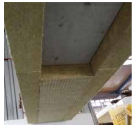
Betonipalkin alapinnan eriste kiinnitetään paloruuveilla.
